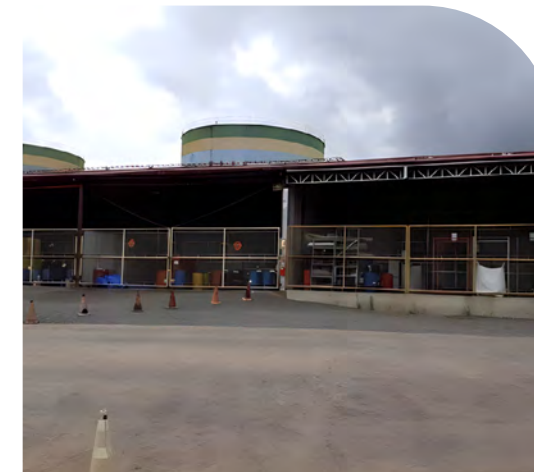
Baia para armazenamento temporário de resíduos - unidade industrial de Ariranha
